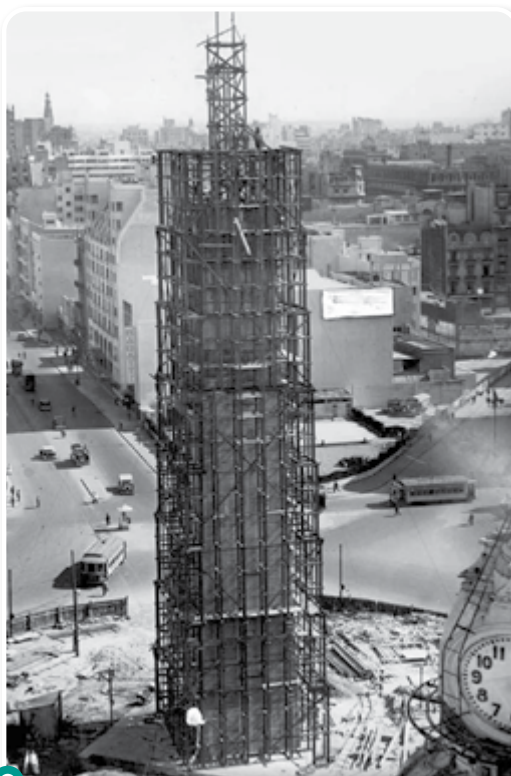
Obelisco en construcción (1936).
