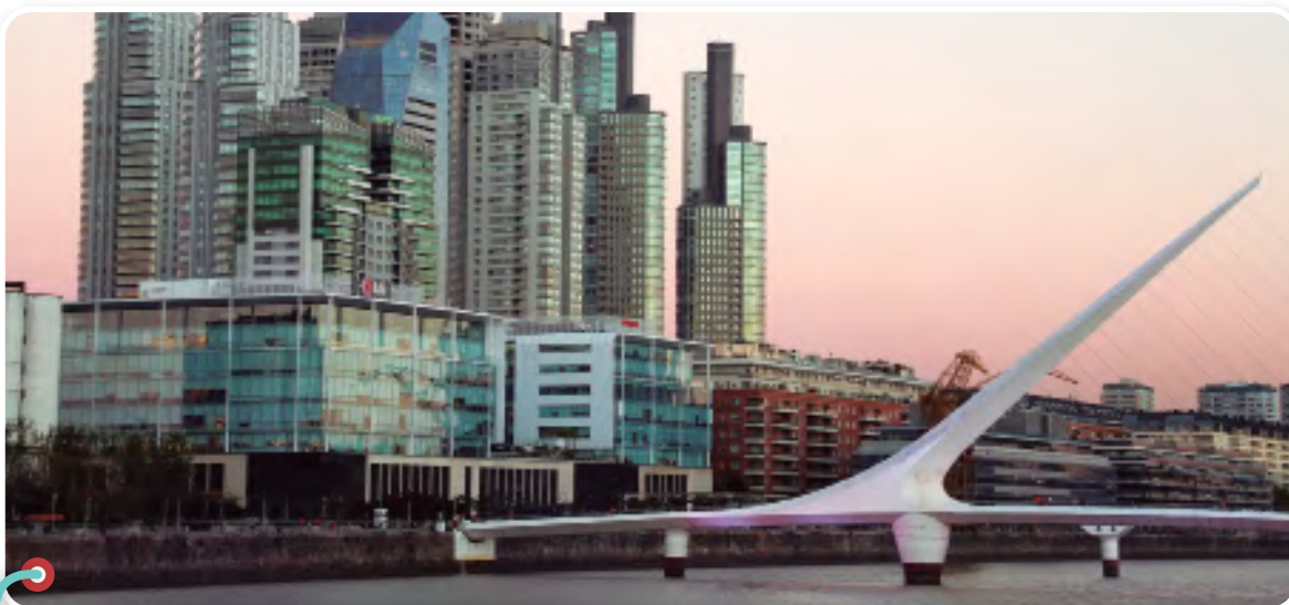
Puerto Madero en la actualidad.
