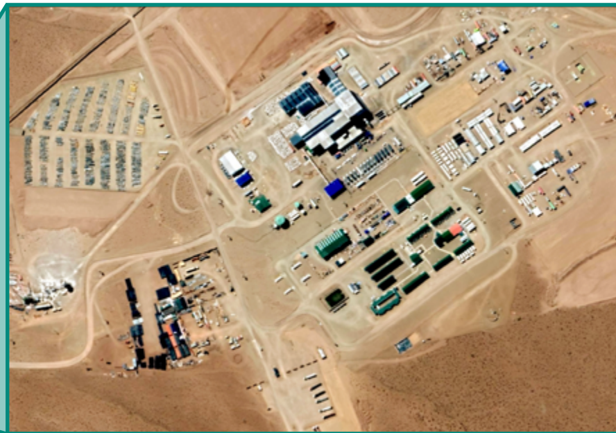
Zona de infraestructura en las cercanías del Salar de Olaroz.
