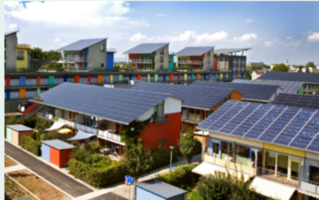
Viviendas en Alemania. El litio es un elemento clave porque permite acumular energía captada por los paneles solares instalados en los techos de las viviendas.
