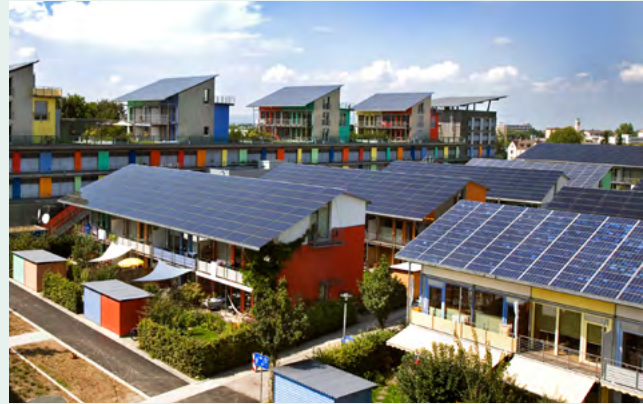
Viviendas en Alemania. El litio es un elemento clave porque permite acumular energía captada por los paneles solares instalados en los techos de las viviendas.
